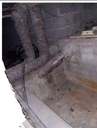
Déclaré - : R-1 / CAVE - Conduit - EP- (Présence d'amiante)
