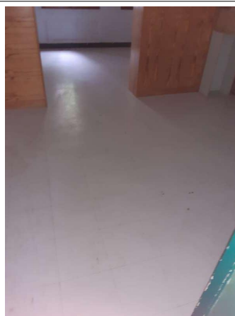
Déclaré - : RDC / CUISINE - Dalle de sol - EP- (Présence d'amiante)
